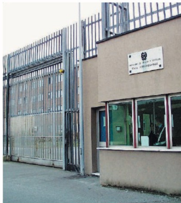
Problemi di scarse pulizie all'interno del carcere del Bassone
