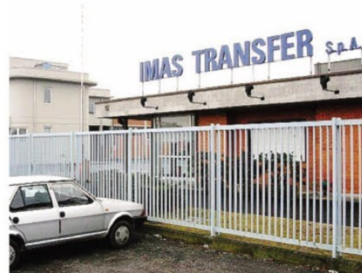
La Imas sta aspettando il pagamento di una commessa in Cina
