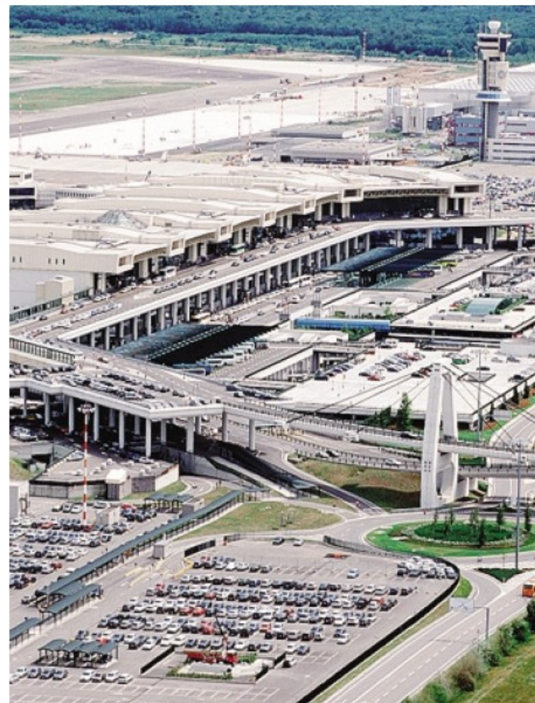
I 350 dipendenti della Dufrital lavorano tra il T1 e il T2 di Malpensa
