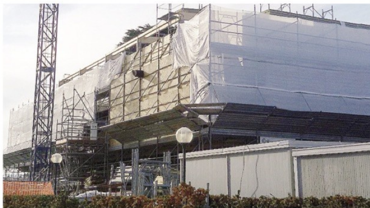
Il cantiere delle nuove sale operatorie: le infiltrazioni arrivano da qui ARCHIVIO
