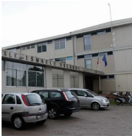
Un'azienda metterà mano alla copertura della scuola Ismaele Orlandi
