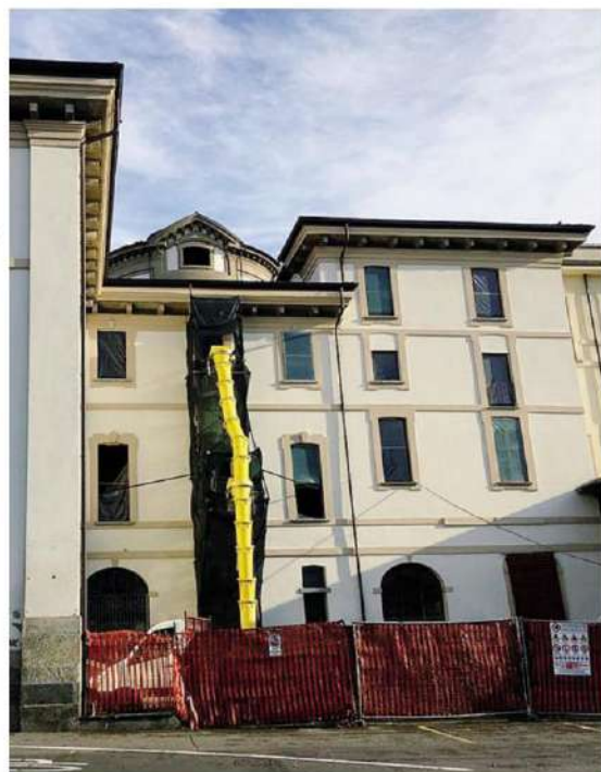
Si va verso la conclusione dei lavori all'ex monastero delle Benedettine
