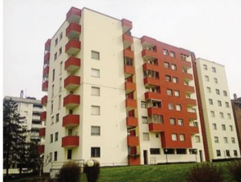
Un intervento di Rete Irene a Rozzano
