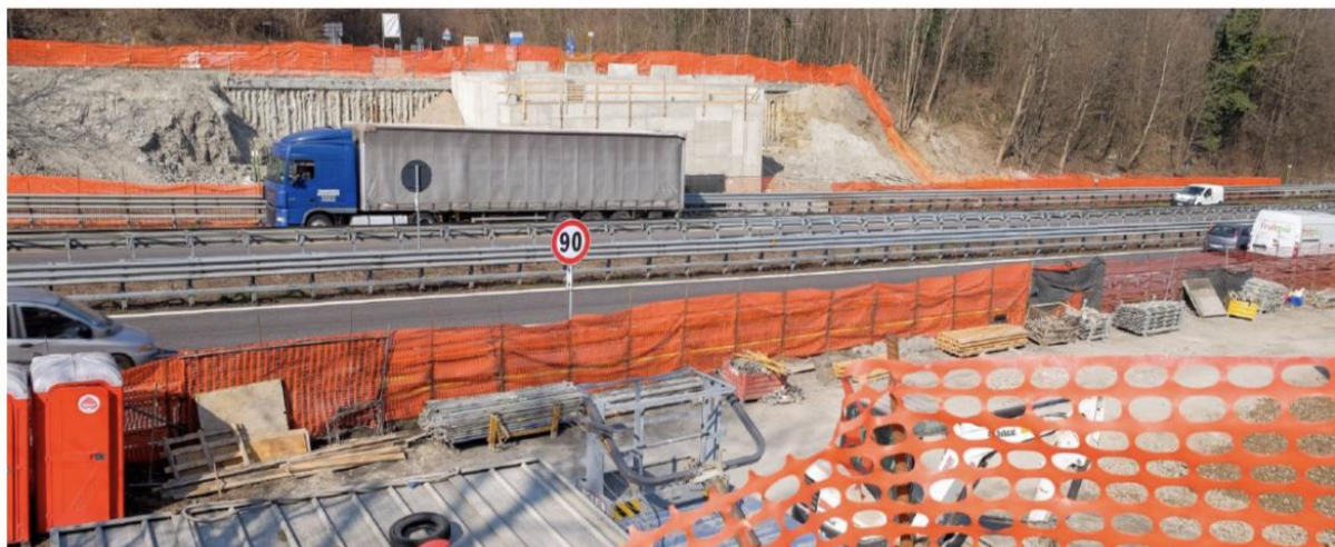
Il cantiere del nuovo ponte è stato "visitato" ieri dal ministro dei Lavori pubblici giunto nel Lecchese per vedere da vicino come procedono i lavori del viadotto iniziati a marzo dello scorso anno
