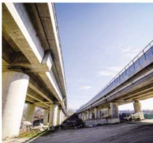
Il primo lotto della tangenziale, lungo appena 2,4 chilometri
