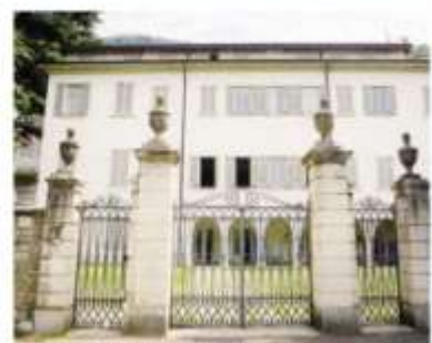
L'immobile che ospita la nuova casa di riposo (1/7)
