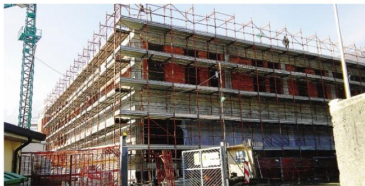
Il cantiere delle elementari che apriranno a settembre
