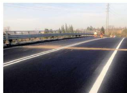
Il ponte del Lottolo è già stato riasfaltato, nuova anche la segnaletica
