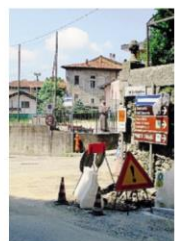
Uno scorcio dei lavori a Drezzo
