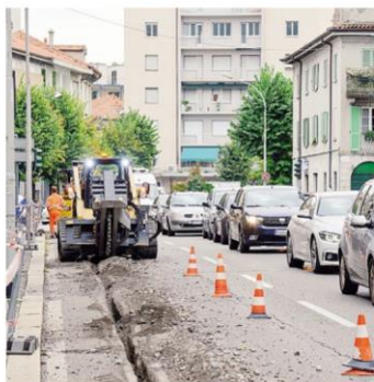
Il cantiere in viale Roosevelt che ha bloccato la città nei giorni scorsi
