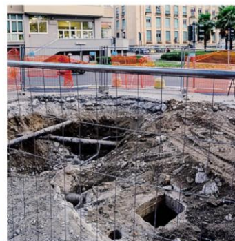
Lavori anche in viale Cattaneo
