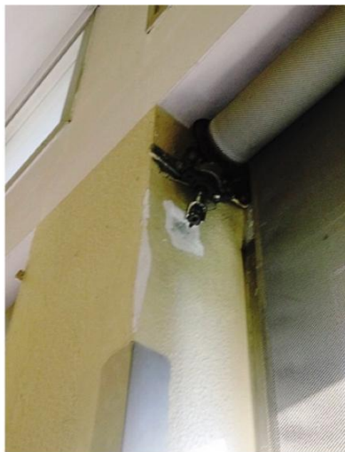
Una tenda rotta: attesa da mesi la riparazione
