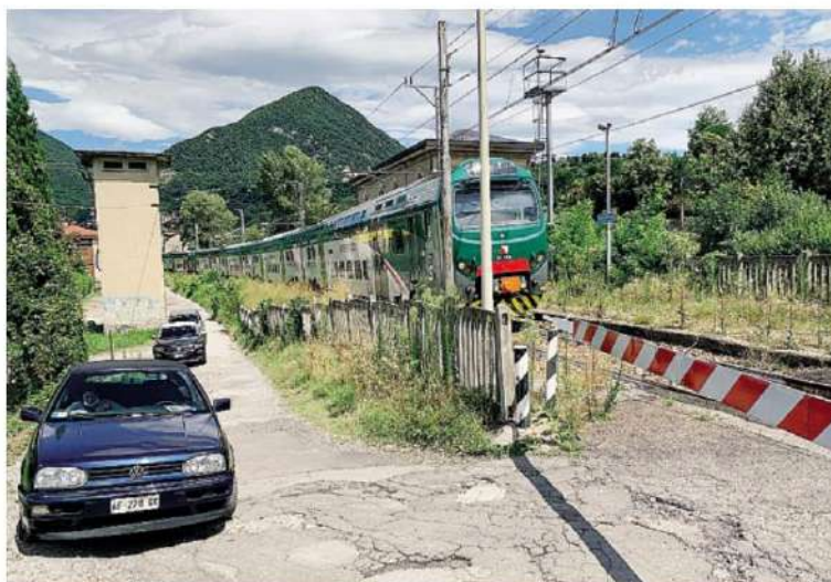
Il passaggio a livello di Carpesino separa Erba da Ponte Lambro. BARTESACCHI
