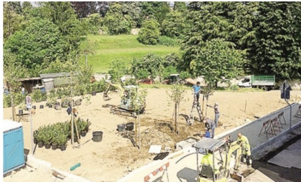
Una foto dei lavori a Carcano nei giorni scorsi FOTO BARTESAGHI
