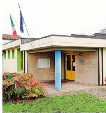
La scuola dell'infanzia di Navedano, frazione di Senna
