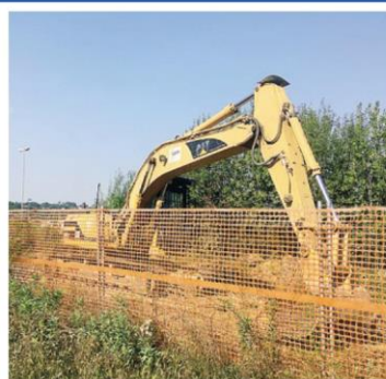
Le ruspe hanno ripulito nei giorni scorsi il cantiere di corso Europa
