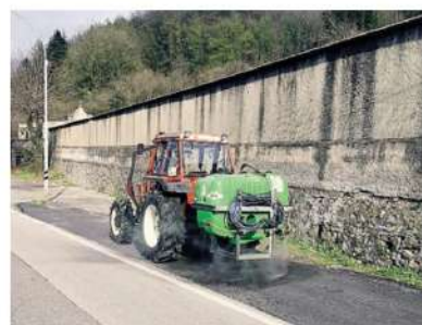
L'intervento in corso a Vaibrona BARTESAGHI
