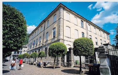
La scuola di via Perti a Como verrà presto interessata da un cantiere
