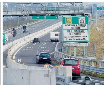
Nessuna buona notizia per la Pedemontana e, in particolare, per la tangenziale
