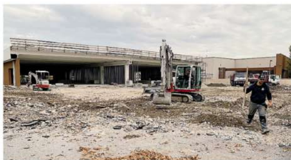
I lavori in corso all'ex Tisba dove sorgerà l'ampliamento dell'Iperal (BARTESAGHI)
