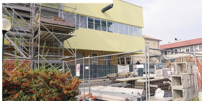
Proseguono i lavori per il nuovo blocco delle sale operatorie
