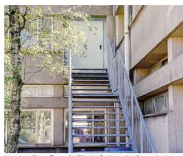
La scala antincendio verrà utilizzata da alcune classi per entrare
