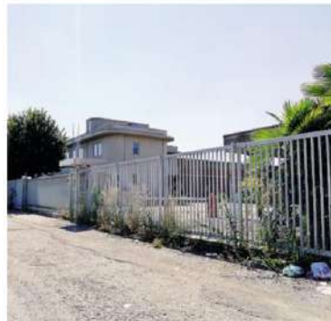
Ecco come si presenta l'area dismessa ex Dell'Orto di viale Lombardia
