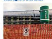
Il cantiere in via Sparta
