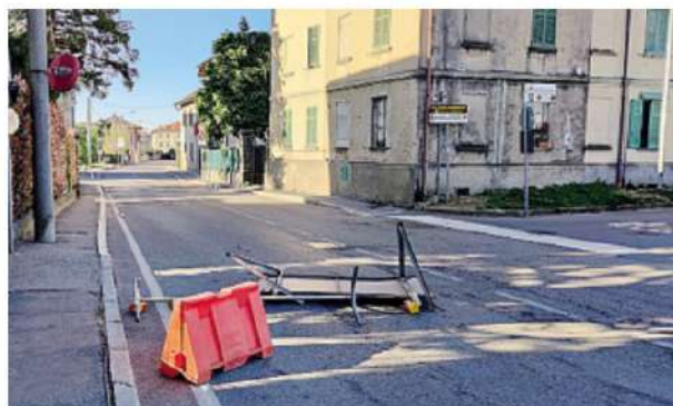
Un'altra transenna abbattuta in via Milano
