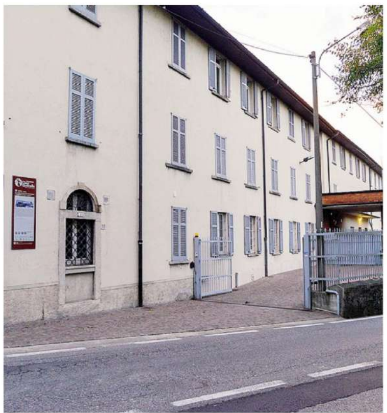
L'ingresso della casa di riposo di Lora
