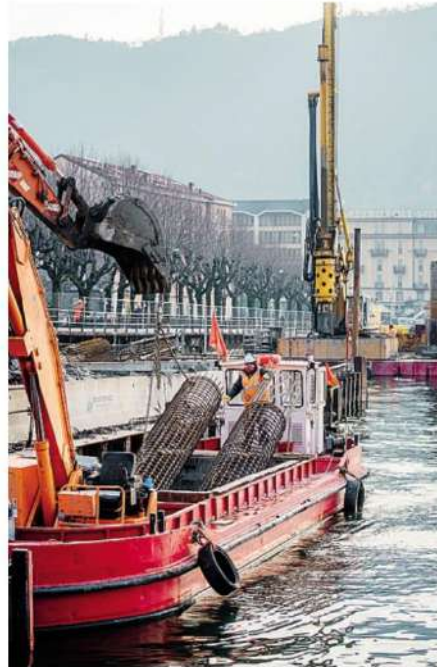
Operai e mezzi sul cantiere delle paratie BUTTI
