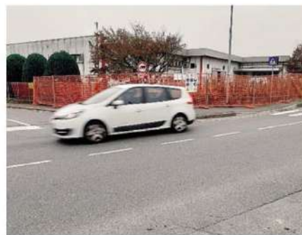
Lavori in corso sulla Provinciale 19
