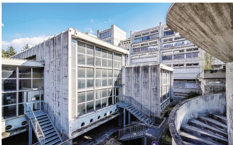
La sede del Setificio, in via Castelnuovo
