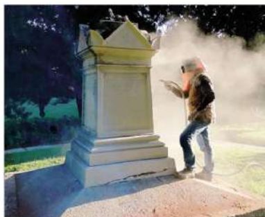
L'intervento di pulizia del cippo al parco di villa Calvi
