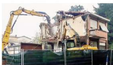
Un'altra immagine della demolizione dello stabile
