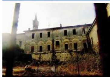
Il castello di Pietrasanta versa in condizioni di grave degrado
