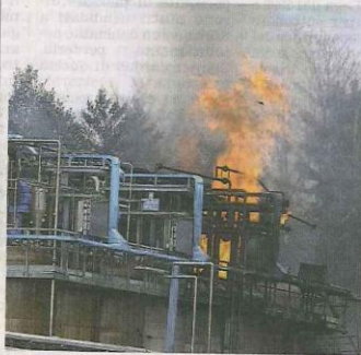
Lo scoppio ha distrutto uno dei serbatoi nel cortile della ditta (Nassa)
