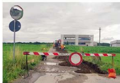
Si sta sistemando via Magistri Comacini per poi passare a via Carovelli
