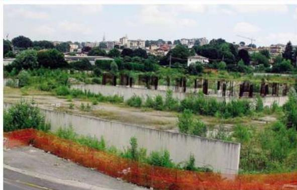
Dei Palaturra di Cantù sono state realizzate solo le fondamenta con le armature, ora arrugginite
