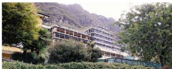
Il nuovo complesso di Parco San Marco in fase di costruzione
