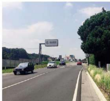
La strada correrà parallela a viale Lombarda per raggiungere Mariano
