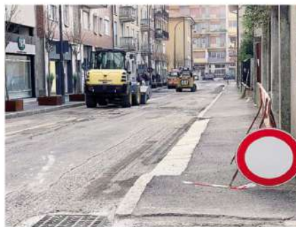
In via Plinio sono iniziati i lavori attesi da tempo BATESAGHI
