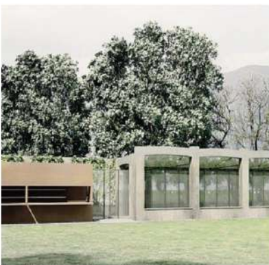
Una vista dall'esterno del manufatto rimesso a nuovo
