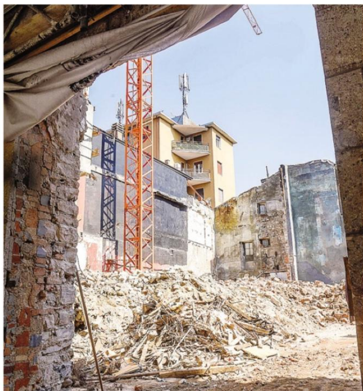
Un cantiere in centro città a Como. Il mercato del mattone si sta riprendendo lentamente ARCHIVIO
