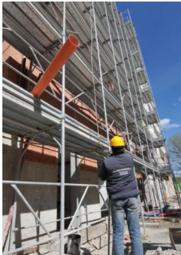
Nuovo cantiere in vista vicino alle sponde dell'Olona
