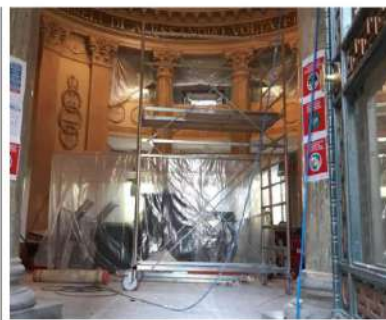
I lavori, iniziati a febbraio e poi interrotti causa Covid, sono ripresi a inizio giugno
