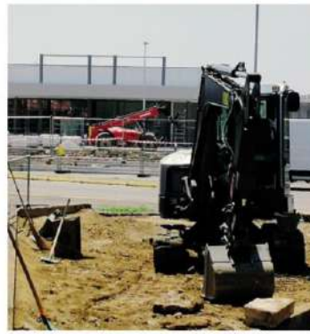
Lavori all'ingresso del nuovo supermercato Iperal di Arosio
