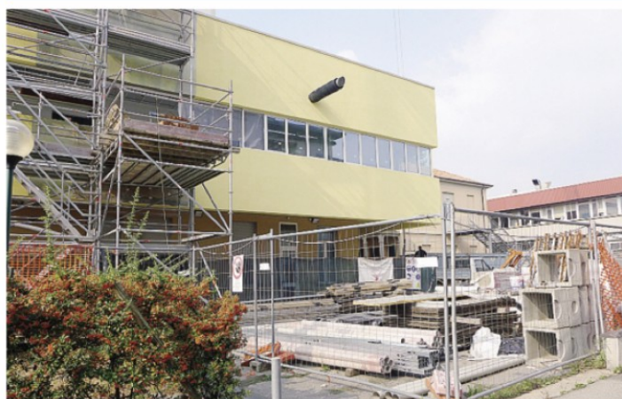
Proseguono i lavori per il completamento del nuovo blocco delle sale operatorie. FOTO BARTESAGHI
