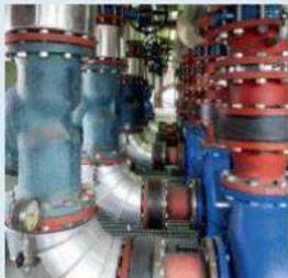
re unico Giuseppina Basalari - è di tipo cogenerativo, capace di produrre sia energia termica che energia elettrica utilizzando gas metano. La potenzialità è di 35 MW termici e 5,4 MW elettrici. Sono stati posati nelle vie cittadine 17,7 chilometri di doppia tubazione coibentata, dotata di telecontrollo. La rete si sviluppa in direzione nord-est a partire dalla centrale e copre la zona centrale della città».
