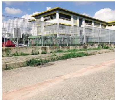
I lavori per la fibra ottica all'esterno dell'istituto Sant'Elia
