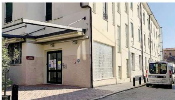
L'ingresso del centro diurno di Ca' Prina BARTESAGHI
