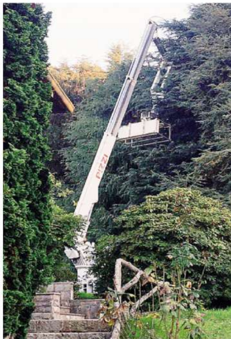
Il braccio della gru spezzato in due e il carrello ribaltato
