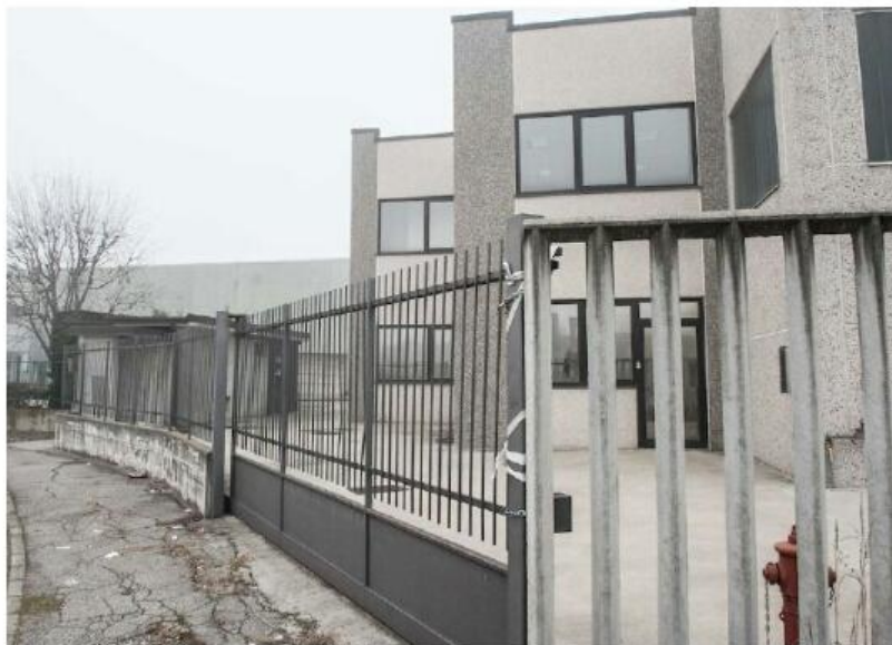
I capannoni lonatesi della casa di moda Dolce & Gabbana in viale Giovanni XXIII (foto Blitz)
