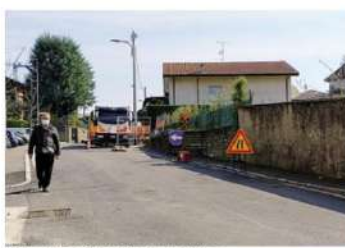
L'intervento in via Boselli per la rete del gas
