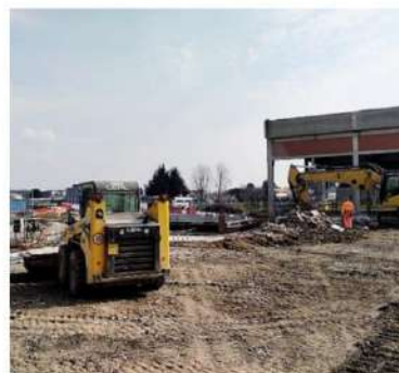
Il cantiere di viale Lombardia, dove aprirà un supermarket Iperal
