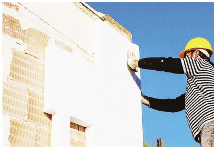
Intervento di riqualificazione energetica su un edificio
