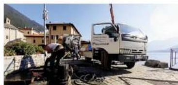
Un cantiere della società comasca
