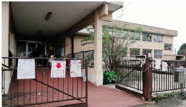
L'ingresso dell'asilo nido Magnolia in via Parini
