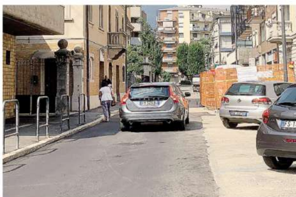
Via Plinio è stata riaperta al traffico, ma i lavori riprenderanno da lunedì. BARTESAGHI
