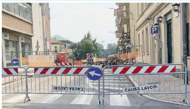
Le transenne che bloccano il traffico su corso Unità d'Italia dove si lavora sul cavalcavia. FOTO BARTESAGHI
