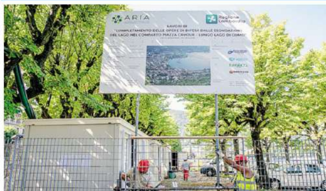
Il cartello sulla recinzione del cantiere riporta la data di conclusione dei lavori BUTTI
