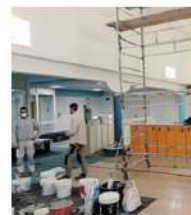
Lavori in viale Roncoroni
