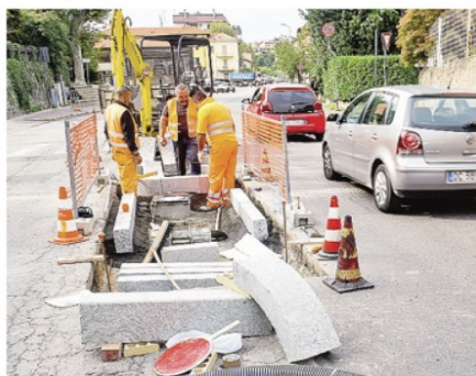
I lavori per la realizzazione dei nuovi spartitraffico in via Bellinzona
