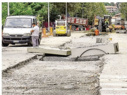
La situazione attuale nel cantiere di via Giussani
