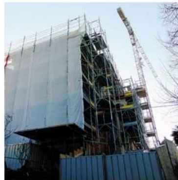
Le impalcature che ancora circondano San Vincenzo
