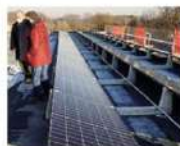
Il fotovoltaico sul tetto
