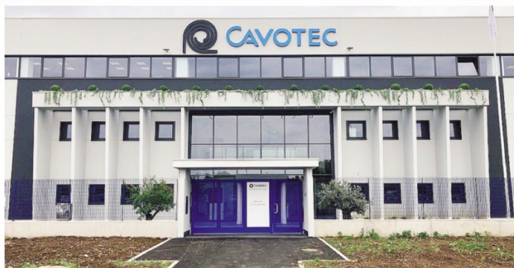
A Nova Milanese la realizzazione della Cavotec, società specializzata nella realizzazione di componenti elettrici ad alta tecnologia
