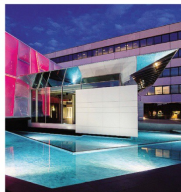
A Imola la costruzione della nuova sede della Sacmi
