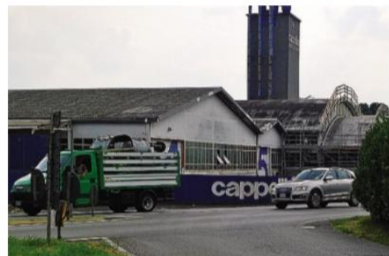
Il cantiere allestito davanti alla fabbrica dismessa ad Arosio
