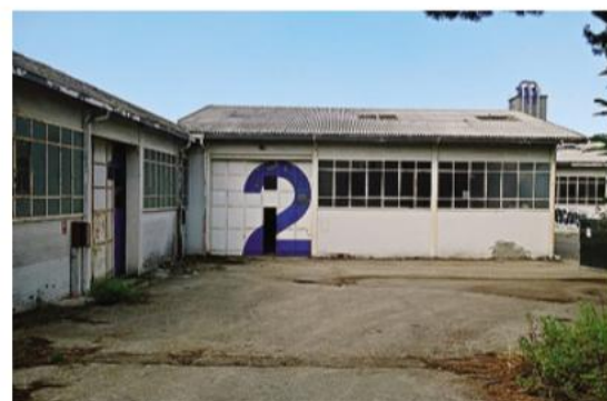
L'interno dell'ex area industriale, a fianco della Novedratese
