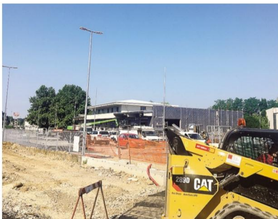
Iniziati i lavori lungo la Provinciale 24 per il nuovo supermercato Carrefour
